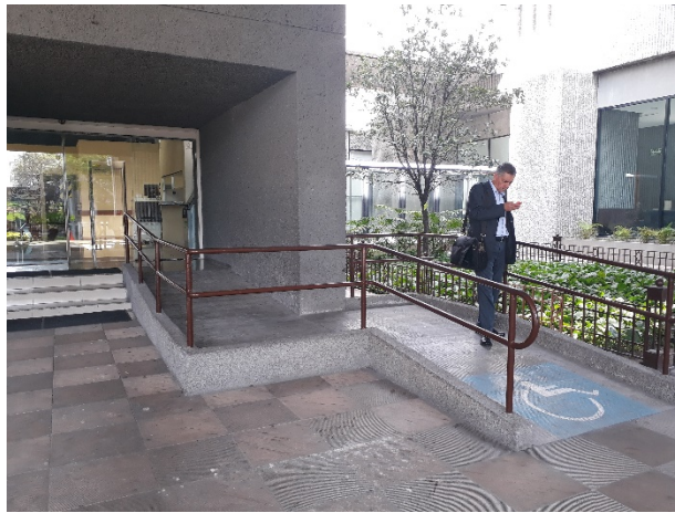
Pasamanos de la rampa larga de acceso, cercana a los cajones accesibles de estacionamiento, frente a calle Matamoros.
