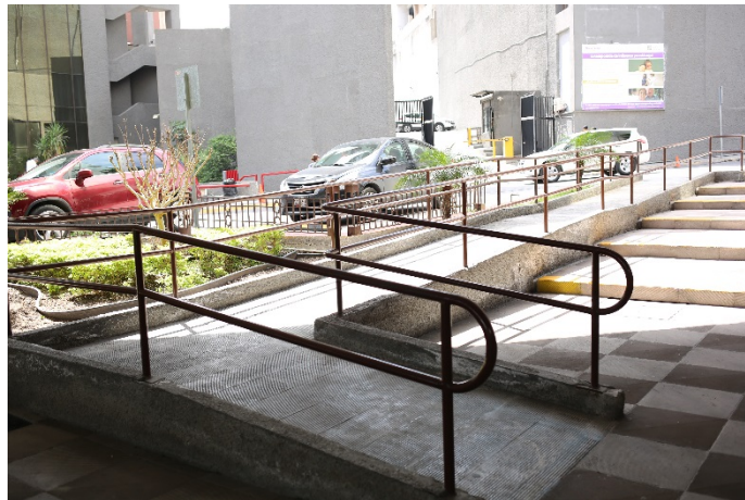
Pasamanos de la rampa interior de primer planta, H. Congreso del Estado.
