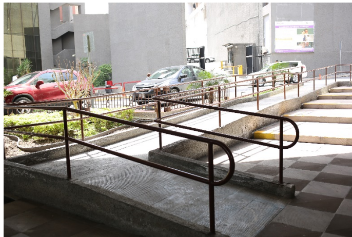
Rampa de acceso a la planta baja, H. Congreso del Estado (entrada principal)
